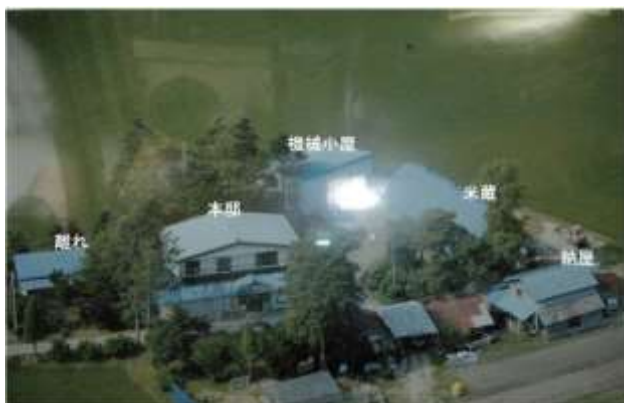
写真 21 旧幅田家住宅全景
