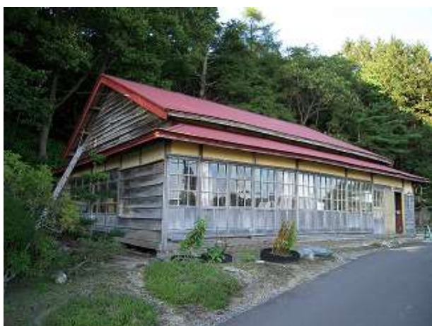
写真5 移築前の旧畑島家住宅の外観
