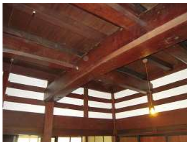
写真6 移築前の旧畑島家住宅の梁組
