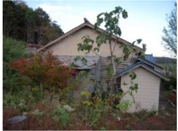
写真10 解体前の旧山口家住宅（西面）
