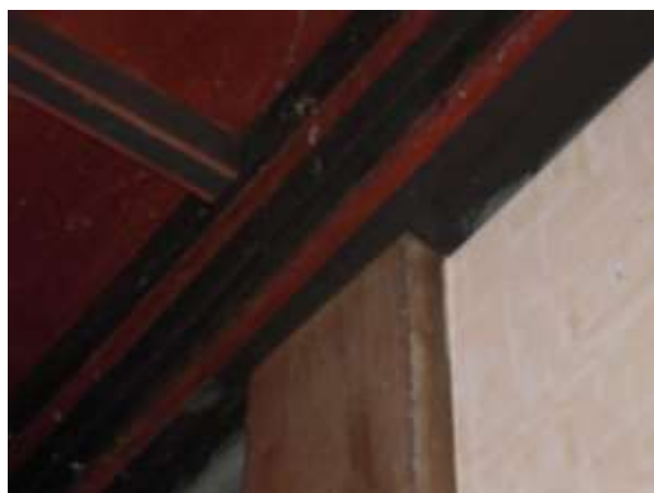
写真 17 ブツマの天井廻縁と格縁
