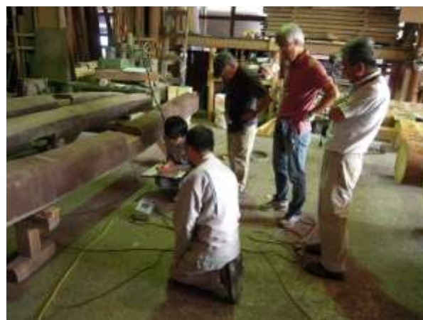
写真8 非破壊検査による強度測定
