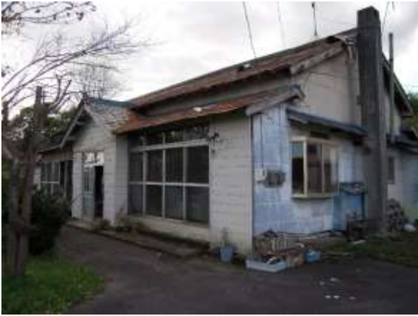
写真9 解体前の旧山口家住宅（東面・南面）
