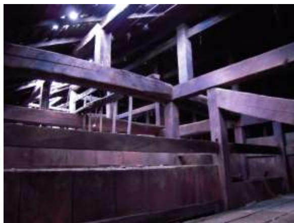
写真 16 小屋組の架構
